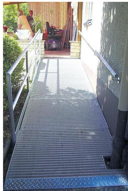
(7) Hier ist die Ausführung einer Sockel-dämmung oder eines Vollwärmeschutzes nicht eingeplant worden
