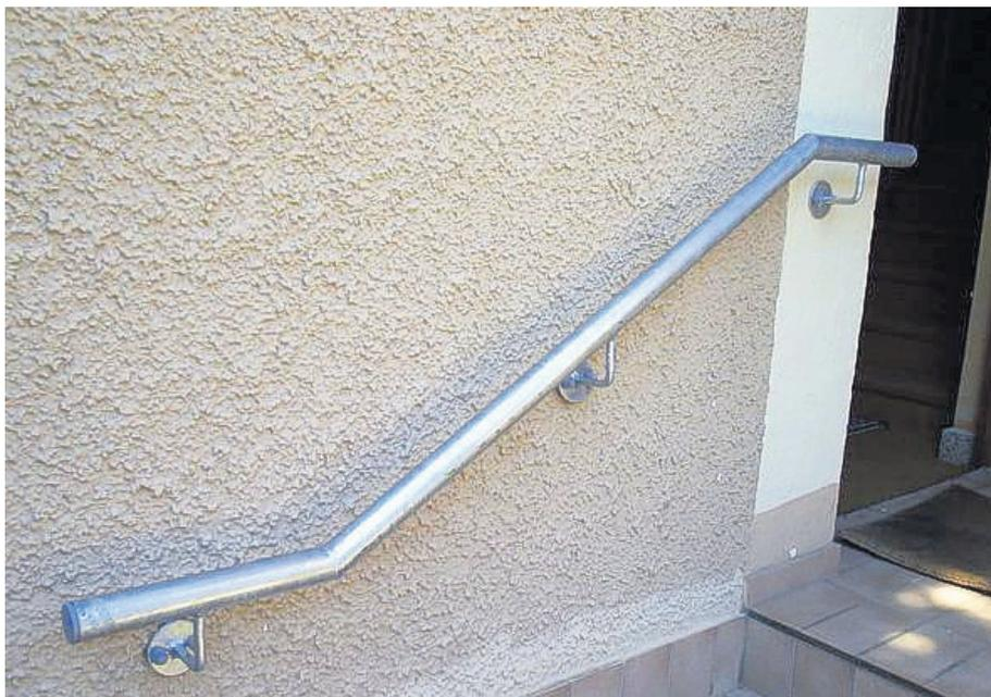
(6) Die Befestigung von Handläufen muss mit ausreichend Stabilität auch im Vollwärmeschutz möglich sein
